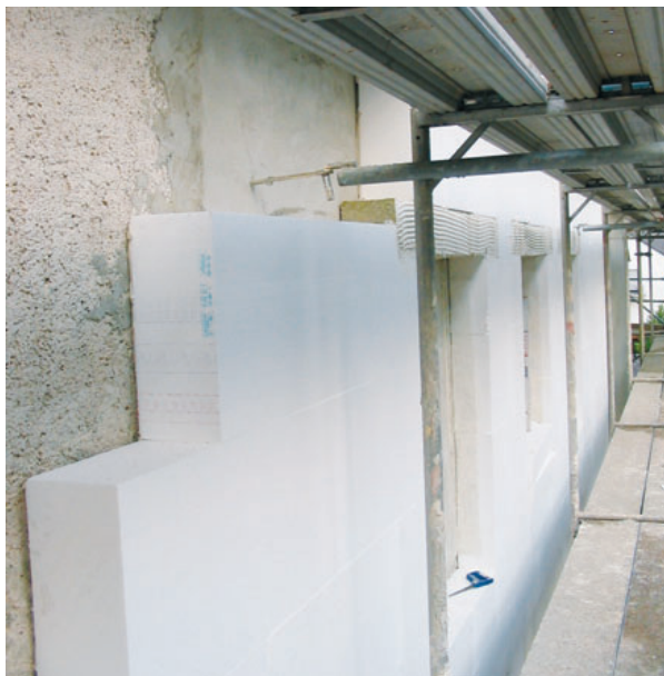
Bild 29: Wärmedämmverbundsystem mit Polystyrol
