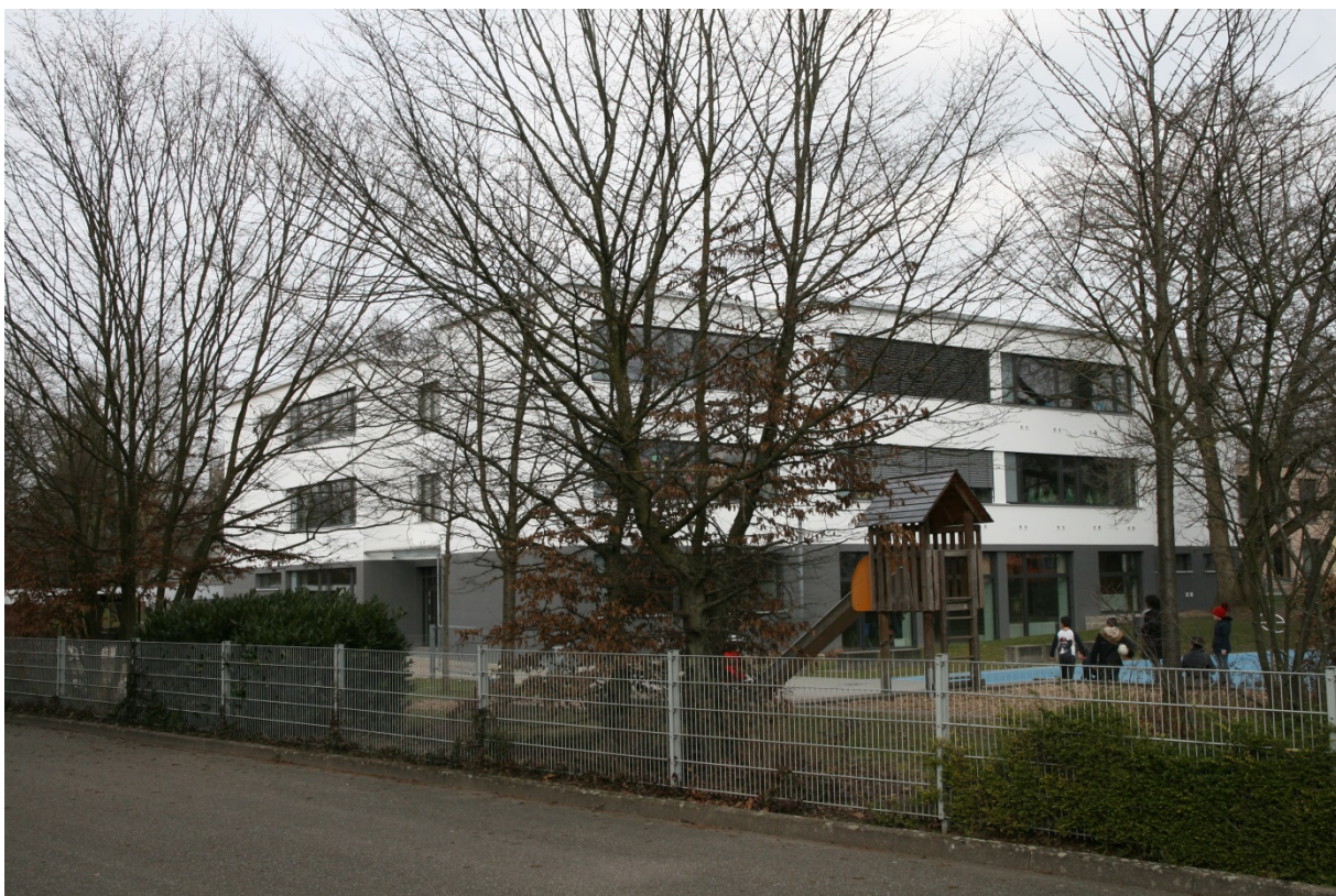
Abb. 1 energ. Modellsanierung Waldbachschule
